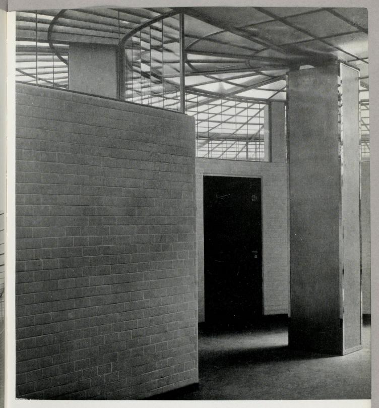
abb. 200 arbeitsamt dessau mittelstütze im kern des shedbaus
