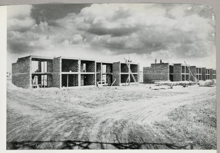
abb. 162 siedlung dessau-törten foto wedekind / dessau bausystem des typs 1927 vor einbringung der füllwände (straßenseite)
