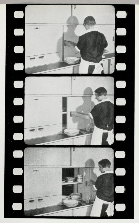
abb. 117 wohnungen der bauhausmeister eingebauter geschirr- und besteckschrank zwischen eßzimmer und spüle, beiderseitig zu öffnen (w. gropius und m. breuer)
