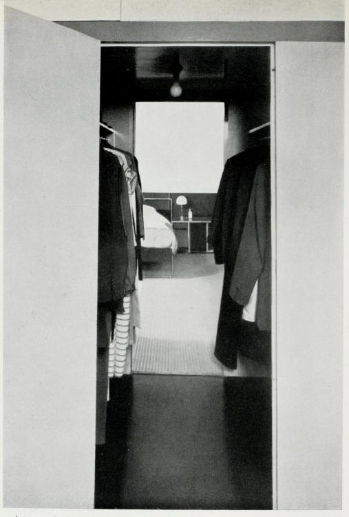
abb. 110 wohnungen der bauhausmeister foto lucia moholy / berlin zwischen zwei schlafzimmern eingebauter begehbarer kleiderschrank im einzelhaus gropius das licht schaltet sich beim öffnen und schließen der tür selbsttätig ein und aus
