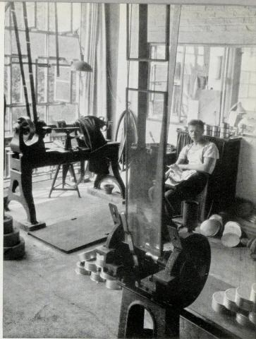
abb. 61 bauhausgebäude metallwerkstatt, drückbank und schleifmaschine
