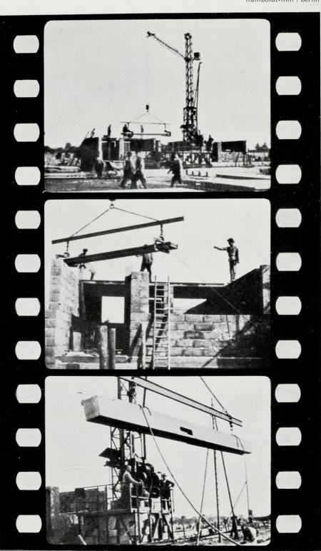
**abb. 160** siedlung dessau-törten turmdrehkran beim versetzen eines armierten betonentlastungsbalkens
