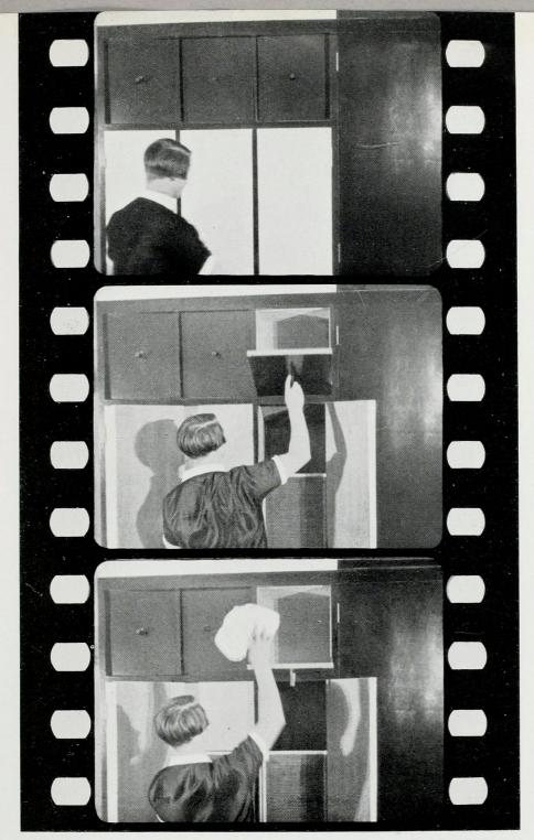
abb. 121 wohnungen der bauhausmeister humboldt-film / berlin dreiteiliger eingebauter schrank für gebrauchte wäsche im treppenhaus des einzelhauses gropius der schrank ist nach außen durch die wand entlüftet. getrennte abteilungen für tisch-, bett- und leibwäsche
