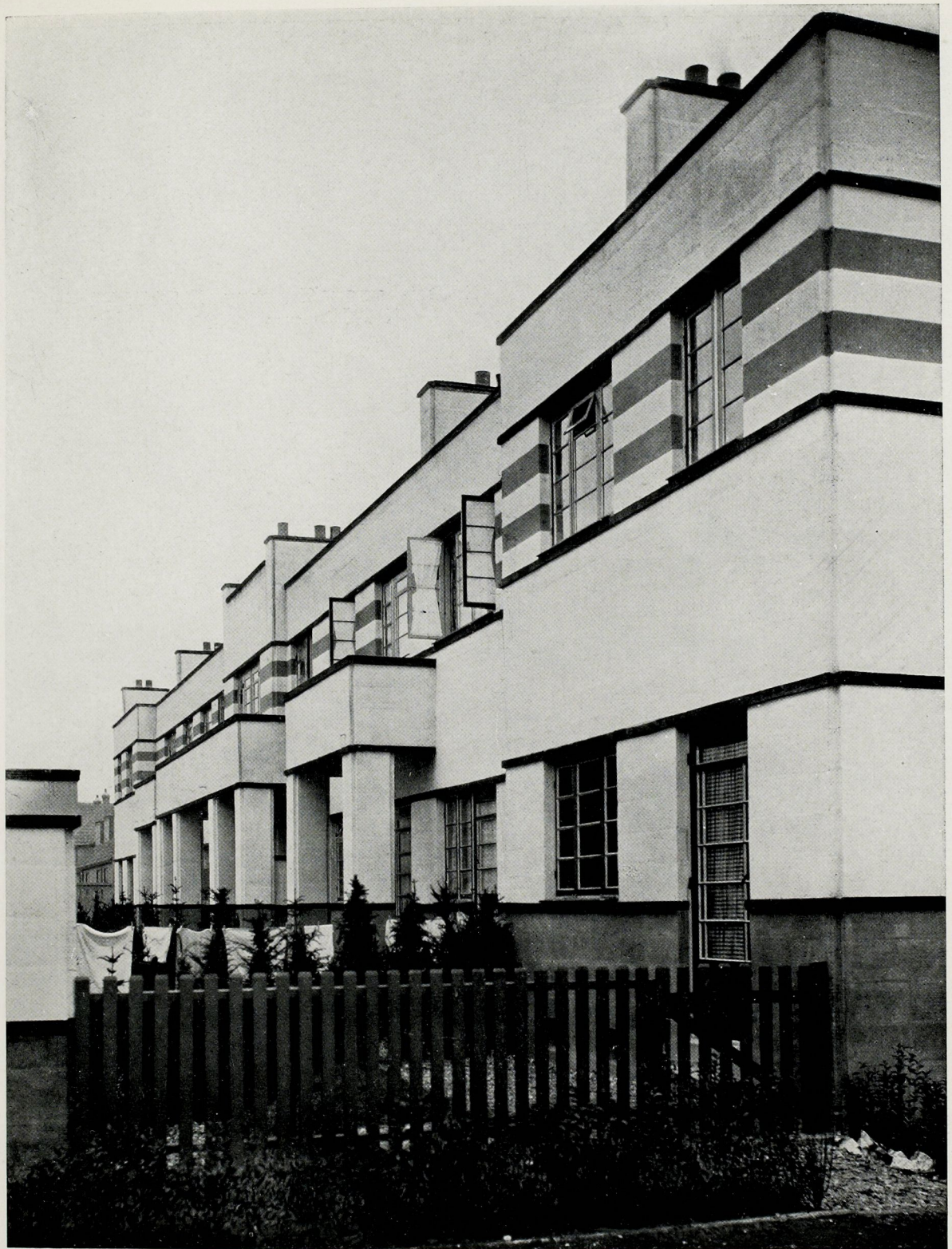
J. M. VAN HARDEVELD, Amsterdam (Holland), — Arbeiterhäuser in Rotterdam aus Betonhohlblöcken. 1921
