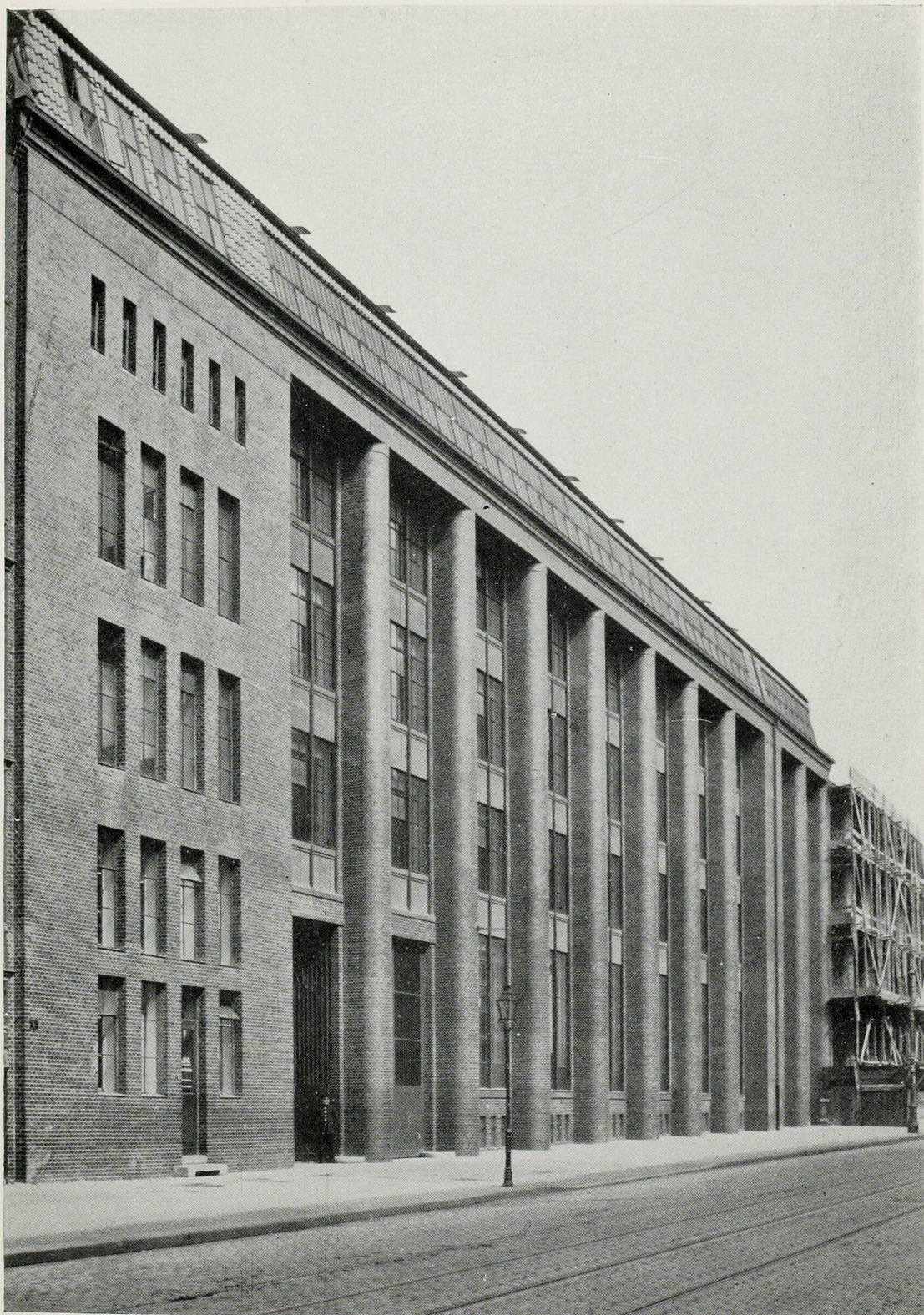
PETER BEHRENS, Neubabelsberg b. Berlin, — Kleinmotorenfabrik der Allgem. Elektrizitätsgesellschaft, Berlin. Verblendziegelbau. 1912
