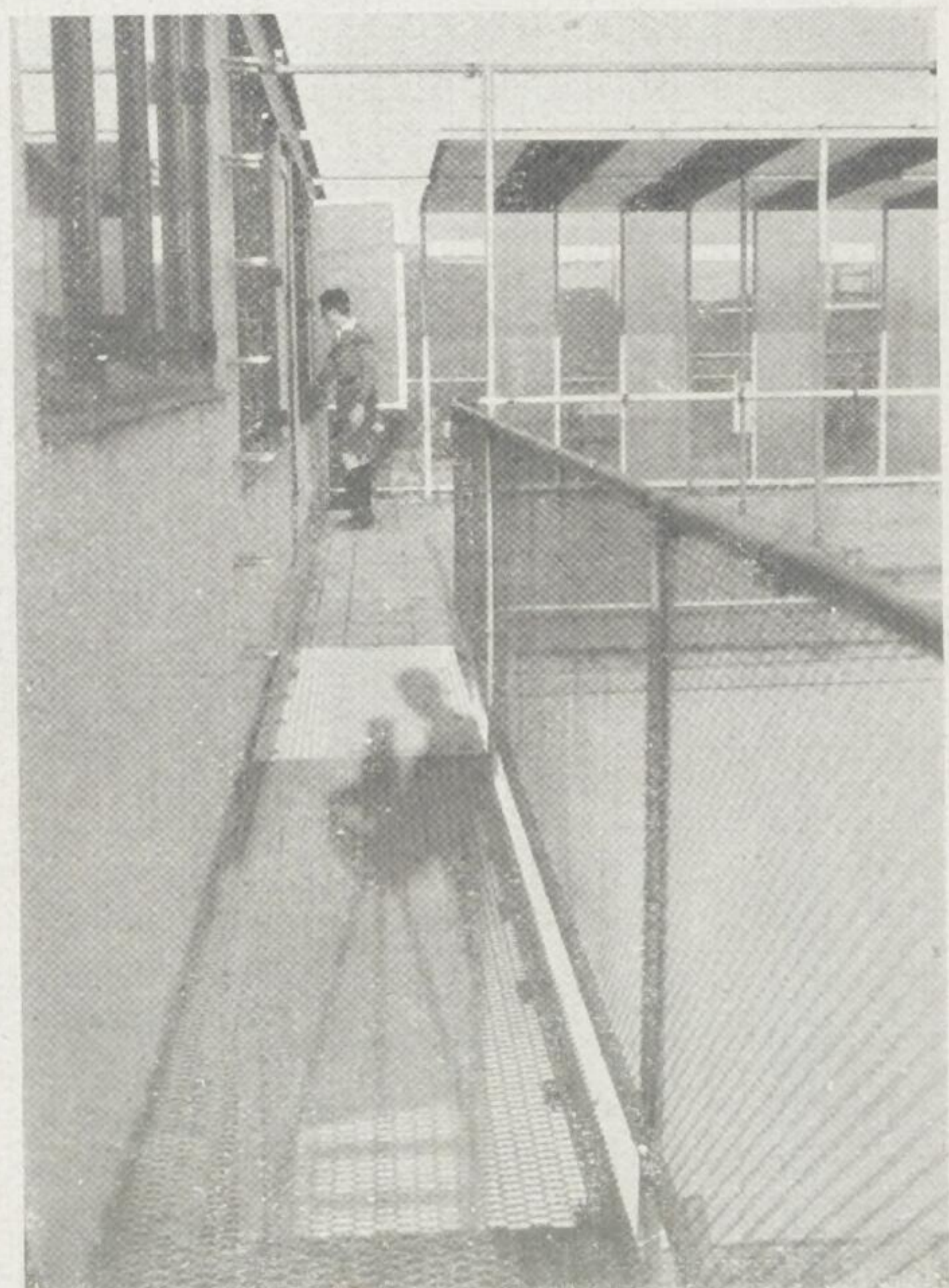
laufsteg zum dachgarten federndes streckmetall auf blechkonsolen
